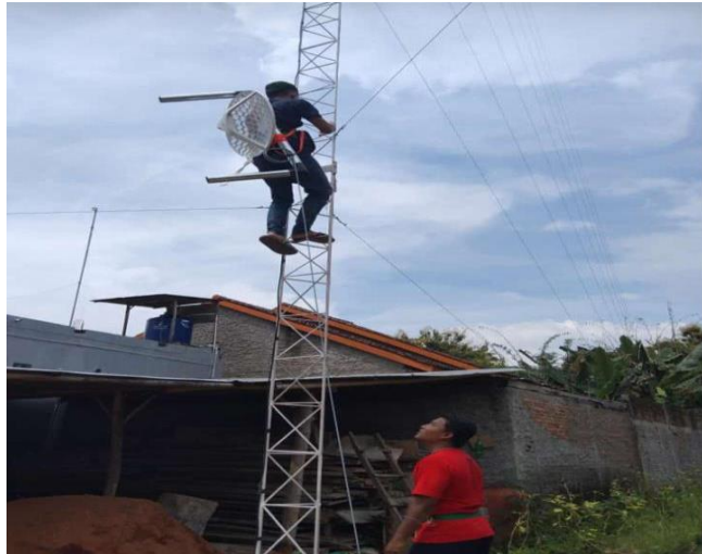
Gambar 4.5 : pemasangan pemancar bitsnet di lingkungan pondok
