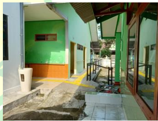
Jamban bagi anak berkebutuhan khusus yang dilengkapi pegangan rambat ( handrail )
