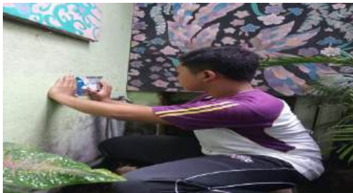
pemasangan slohan hemat air
