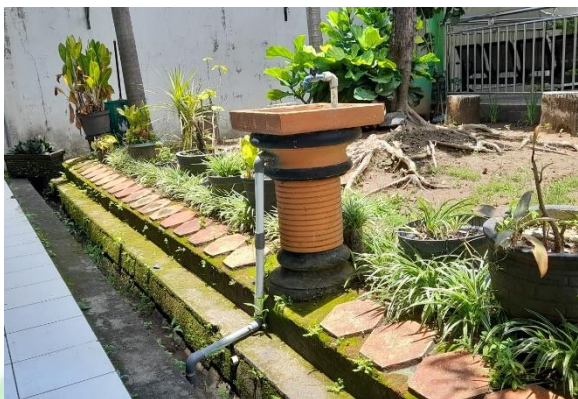
Gambar 4.4. Wastafel Biopori Salah Satu Sarpras yang Menunjang Peduli Lingkungan SMP Negeri 1 Jetis
