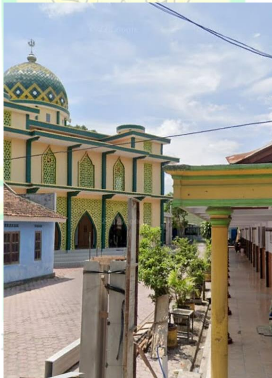
Gambar 4.3 foto masjid setelah direnovasi
