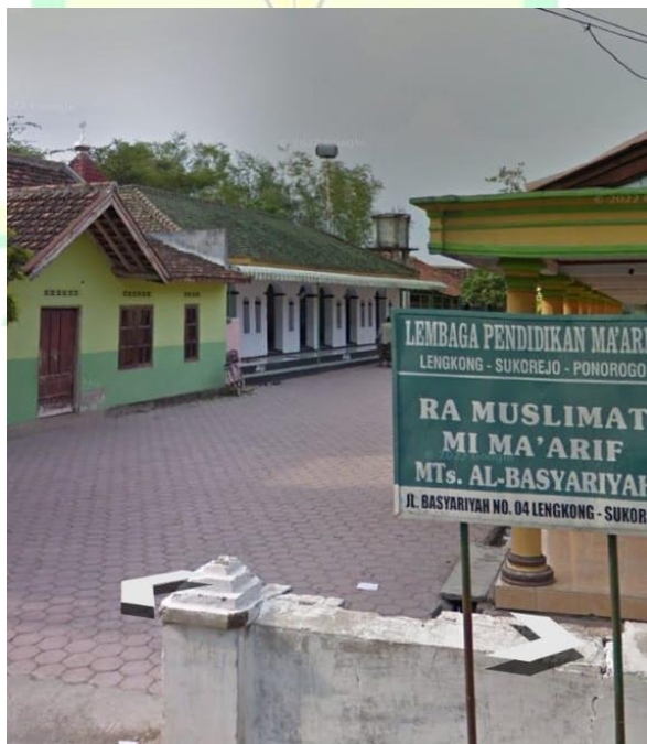
Gambar 4.1 foto masjid sebelum direnovasi
