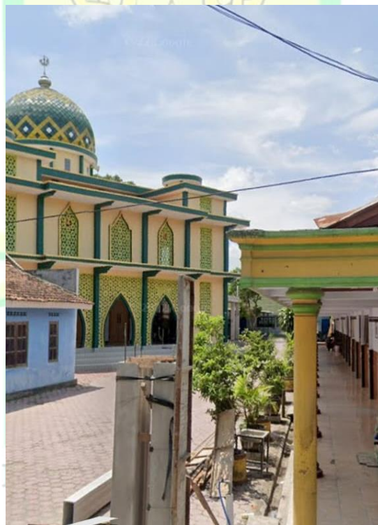
Gambar 4.3 foto masjid setelah direnovasi
