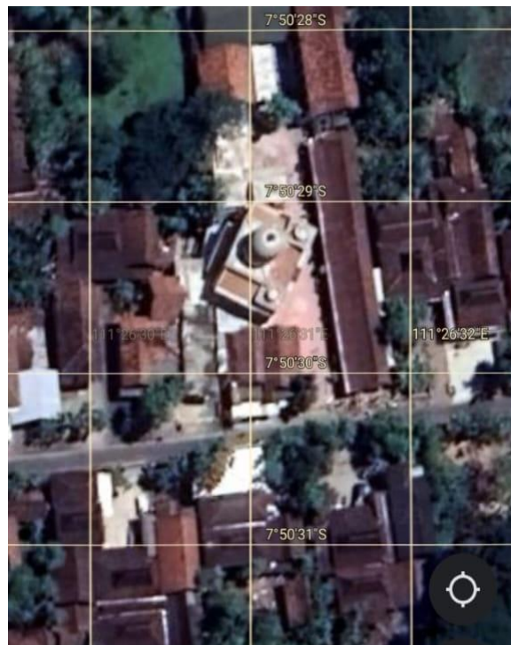
Gambar 4.4 penampakan masjid sesudah direnovasi dari citra satelit
