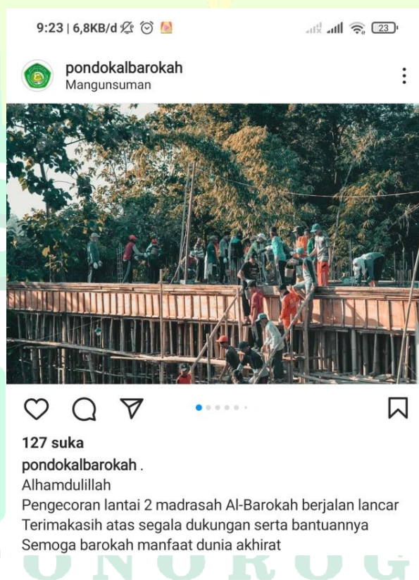
Gambar 4.4. Dokumentasi Kegiatan Pembangunan Gedung Baru
