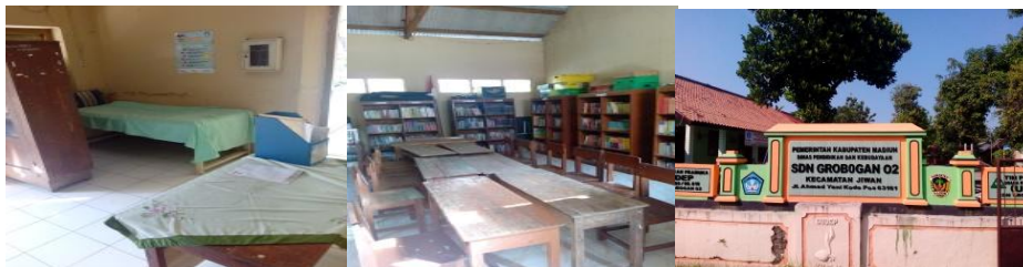
Gambar 4.3 : Kondisi Ruang UKS dan Pagar Depan SDN Grobogan 2
