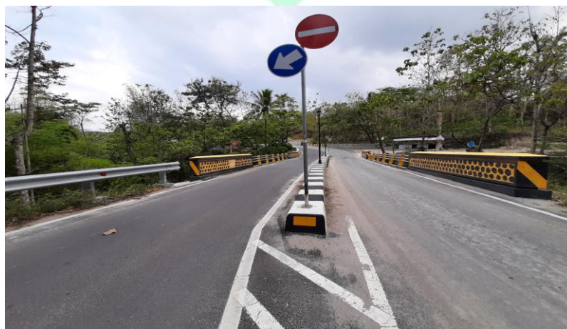
Gambar: Pembangunan Jalan Menuju Tempat Wisata
